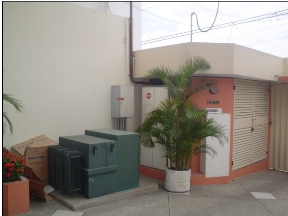
Figura 3.3.1b - Transformador y cuarto del grupo electrógeno
