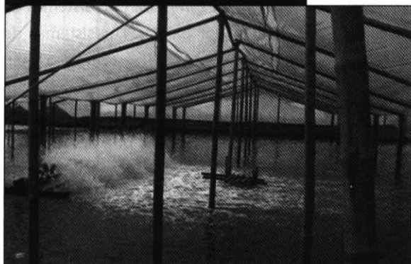
FIGURA 5: INVERNADERO CON ESTRUCTURAS DE CAÑA GUADUA.
