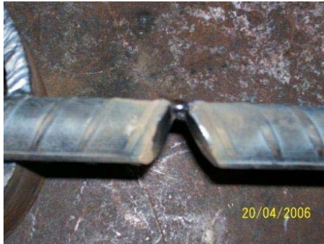
Figura. 3.2 Alineación de la unión a tope en V.
