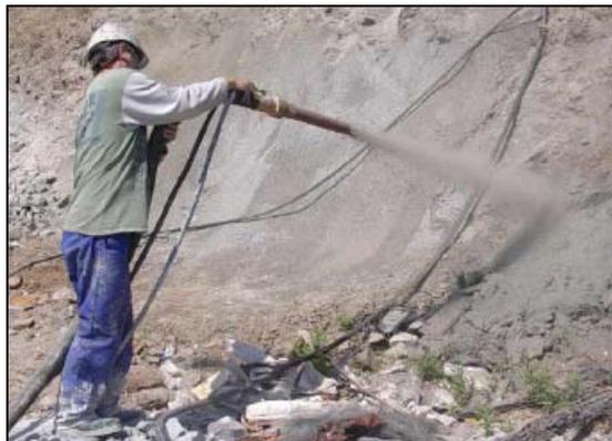
Figura 4.2.2 Aplicación de Hormigón Projectado, Aplicación Seca
