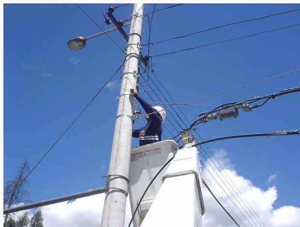
Figura 5-6: Colocación de Herrajes
