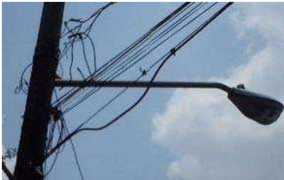
Figura 5-4: Bucle de Expansión
