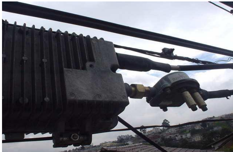
Figura 5-11: Cambio y calibración de Amplificadores
