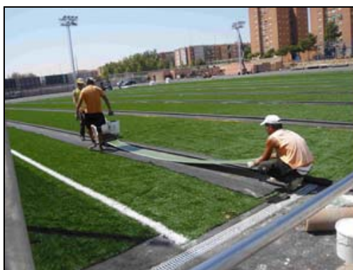
Figura N° 2.36 Unión de rollos de césped sintético
