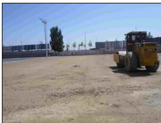
Figura N° 2.31 Compactación del terreno para canchas sintéticas
