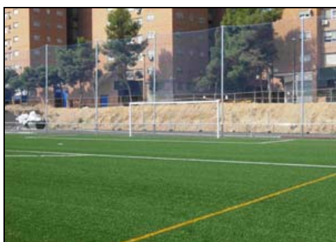
Figura N° 2.42 Cerramiento con malla de nailon
