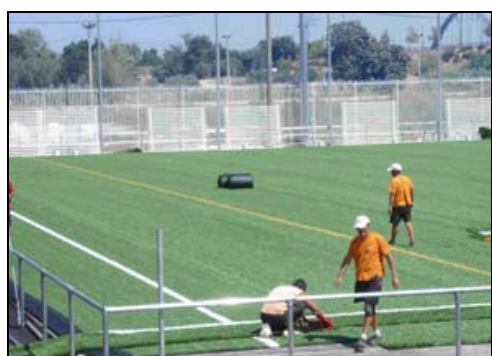
Figura N° 2.37 Colocación de líneas
