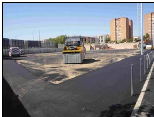
Figura N° 2.34 Asfaltado de terreno para cancha sintética
