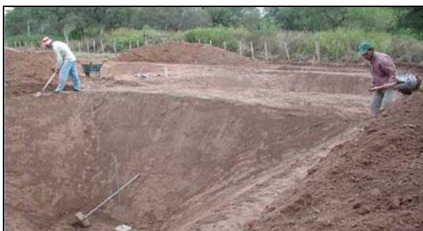
Figura N° 2.30 Excavación del terreno para canchas sintéticas
