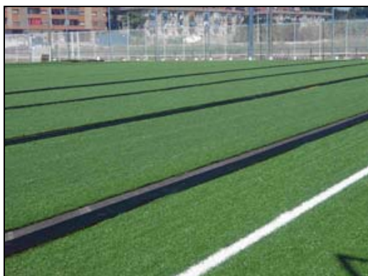
Figura N° 2.35 Tendido de rollos de césped sintético
