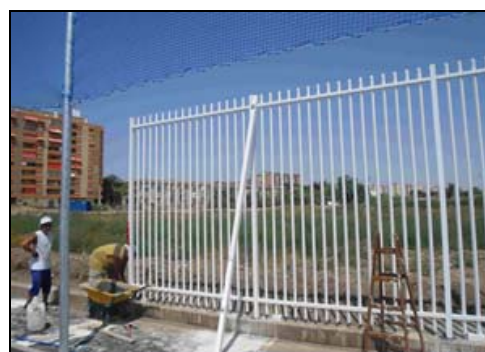
Figura N° 2.43 Cerramiento con malla metálica
