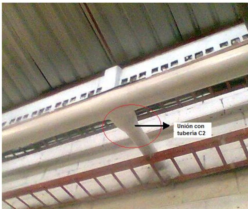
Fig. 2.30 Unión Tramo 7 con tubería C2.
