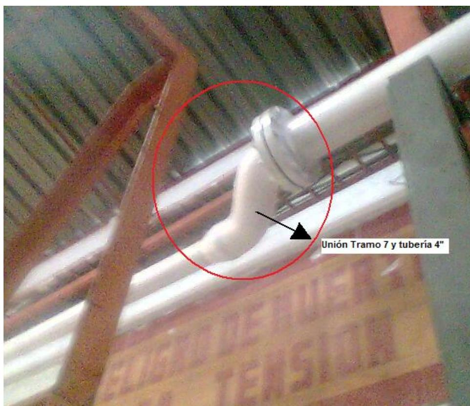
Fig. 2.29 Unión de tramo 7 y tubería 4\".
