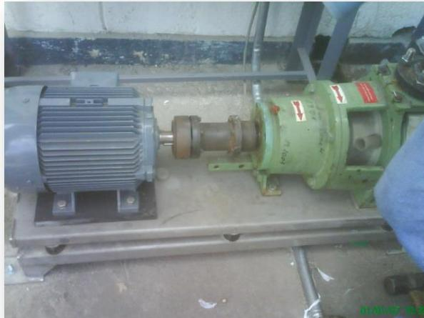
**FIGURA 5.3. BOMBA PARA AGUA DESTILADA QUE ENTRA EN LAS BATERIA**
