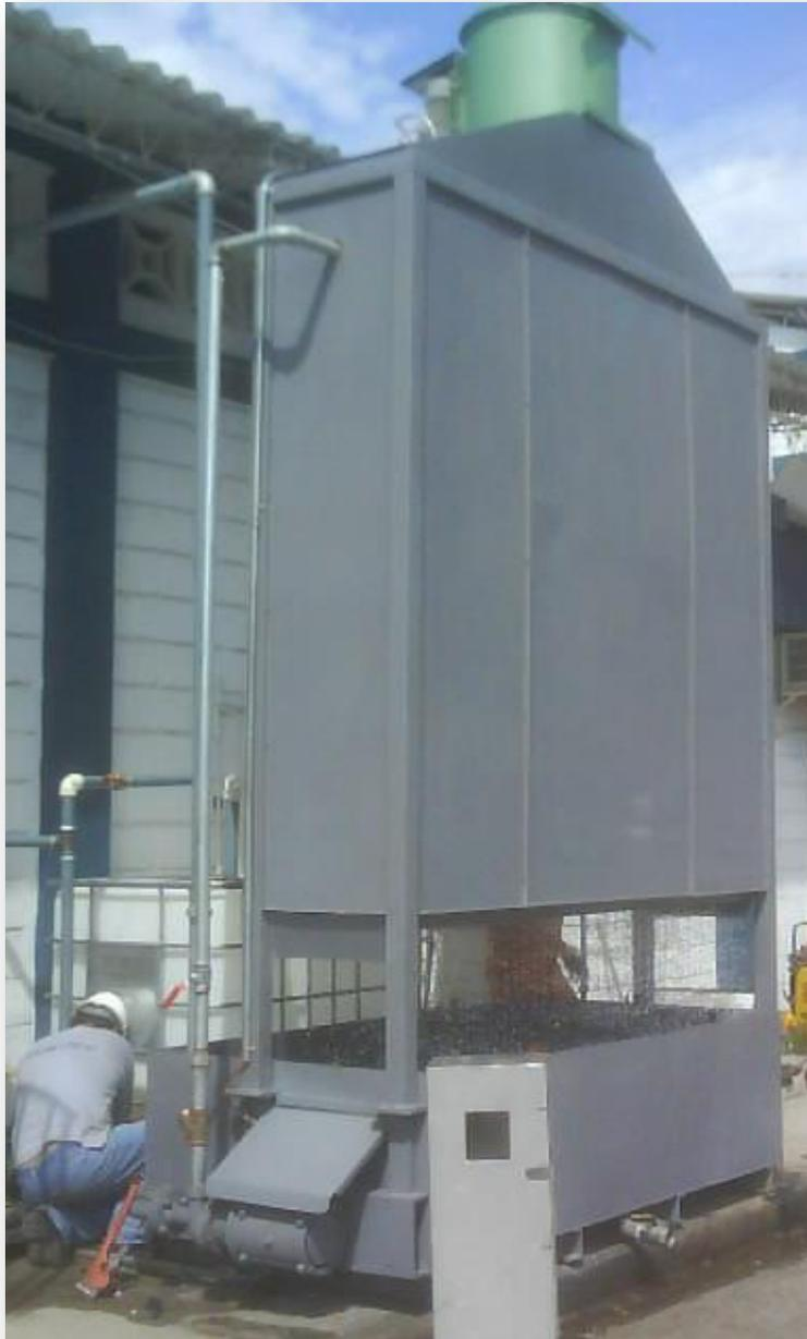
**FIGURA 5.9. TORRE DE ENFRIAMIENTO INSTALADA**
