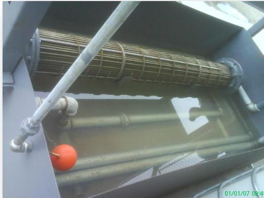
**FIGURA 5.7. INTERCAMBIADOR SUMERGIDO EN
