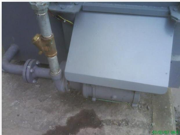
**FIGURA 5.4. BOMBA DE AGUA PARA TORRE DE ENFRIAMIENTO**
