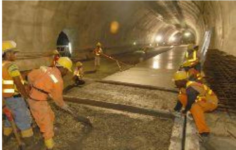
Figura 3.1. Colocación Hormigón Simple en la Vía.
