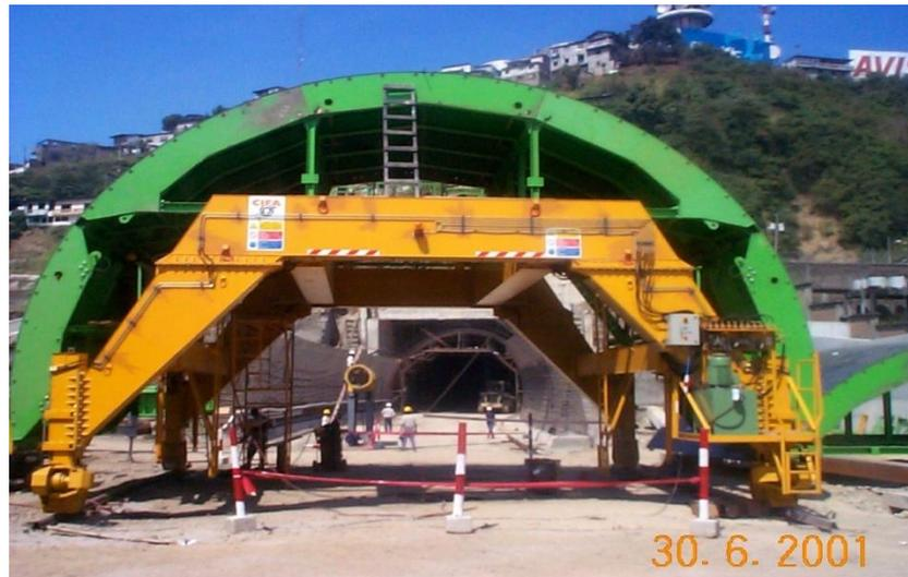
Figura 3.10. Encofrado del revestimiento del túnel.
