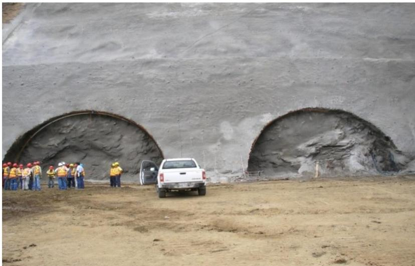
Fig.4.9. Excavación Inicial – Portal Norte
