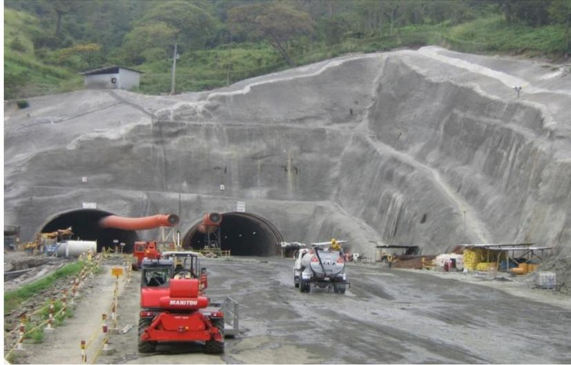
Fig.4.16. Sostenimiento de taludes- Portal Sur
