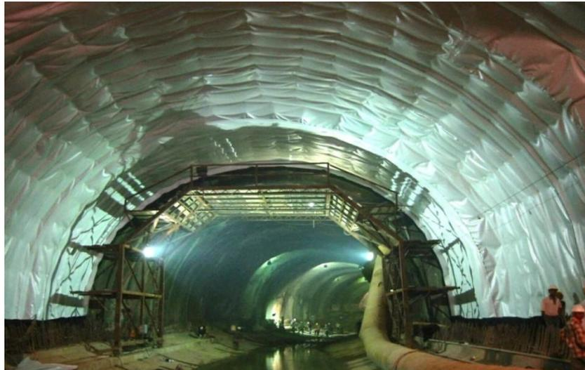
Figura 3.9. Impermeabilización del túnel.
