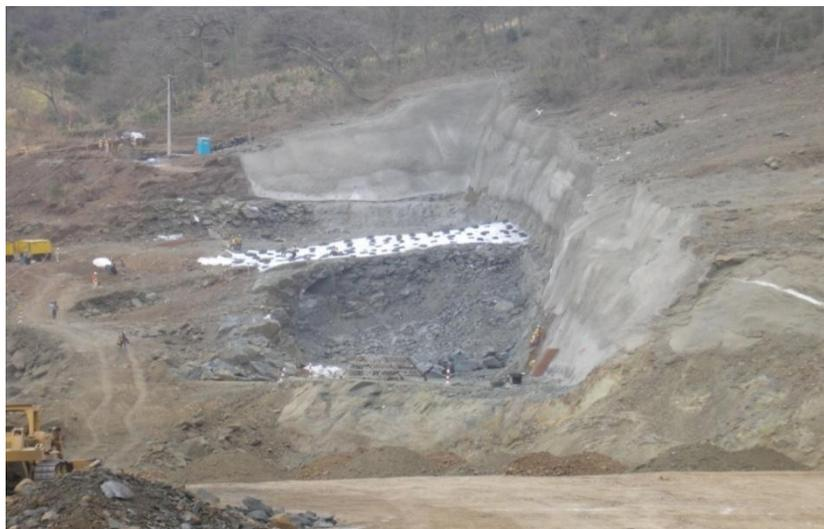
Fig. 4.15. Excavación por voladura – Portal sur.
