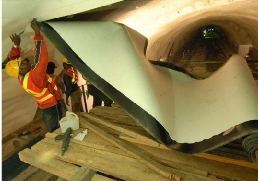
Figura 3.8. Colocación de membrana impermeable.
