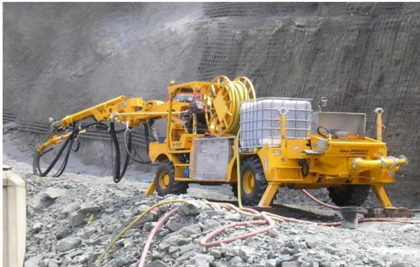
Figura 3.3. Colocación de Hormigón Proyectado en los taludes de los portales del túnel.
