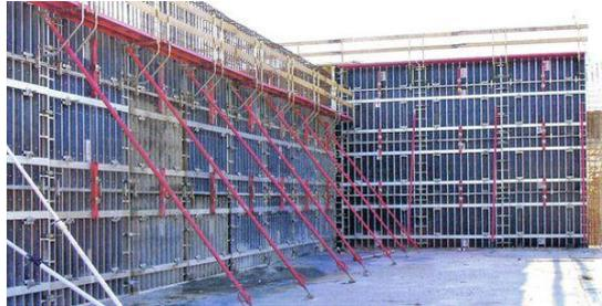
Las superficies de **acero** son impermeables y proporcionan un color uniforme. El revestimiento de acero debe ser lo suficientemente grueso para soportar la carga entre sus elementos de apoyo, con el fin de mantener las deflexiones dentro de límites aceptables.
