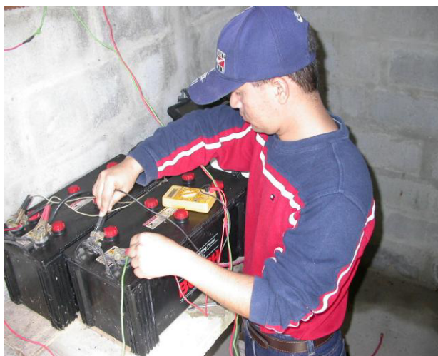
Figura 3.17: Medición del voltaje en las baterías
