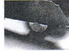
cortando el saliente inferior del anclaje con una cuchilla
