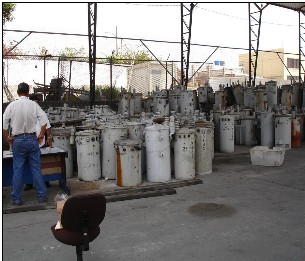
FIGURA 4.1. TIPO DE BODEGA EXISTENTE
