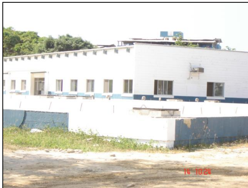
Figura. 3.1 CISTERNA PRINCIPAL DE ALMACENAMIENTO DE AGUA
