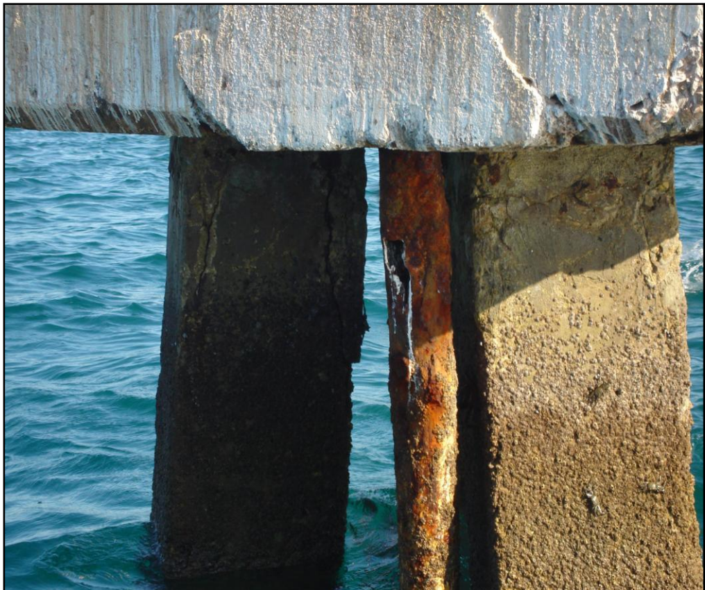
Figura. 3.32 RECORRIDO DE LA OBRA CIVIL EN EL DUQUE DE ALBA
