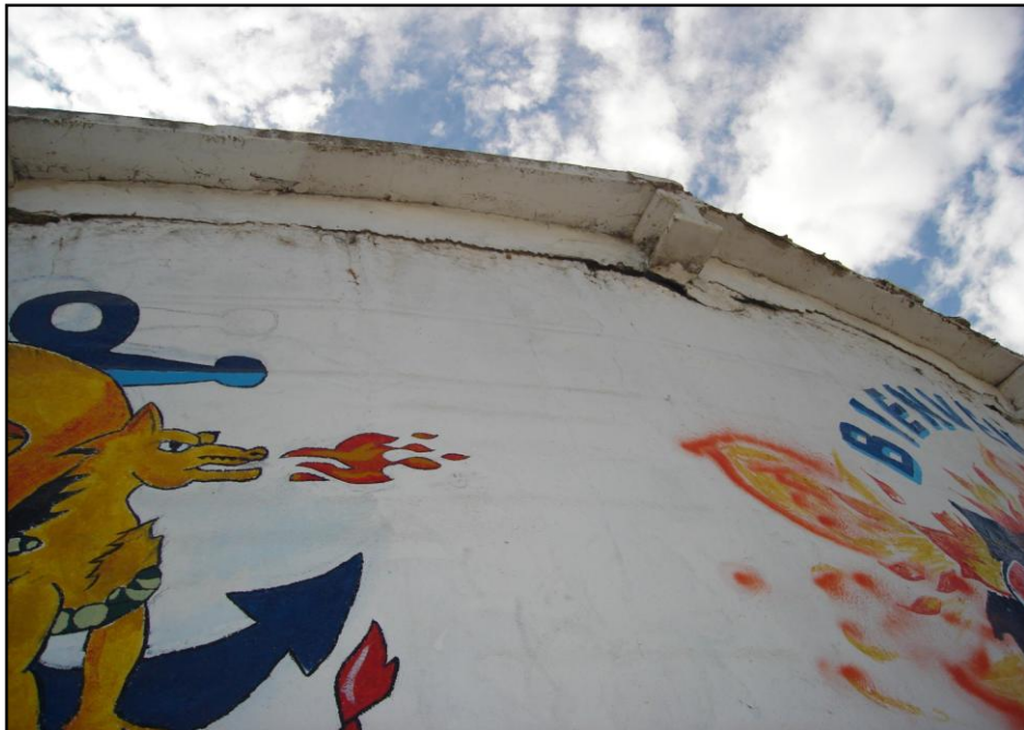
Figura. 3.9 INSPECCION DE LAS PAREDES DE LOS TANQUES CIRCULARES DE CONCRETO
