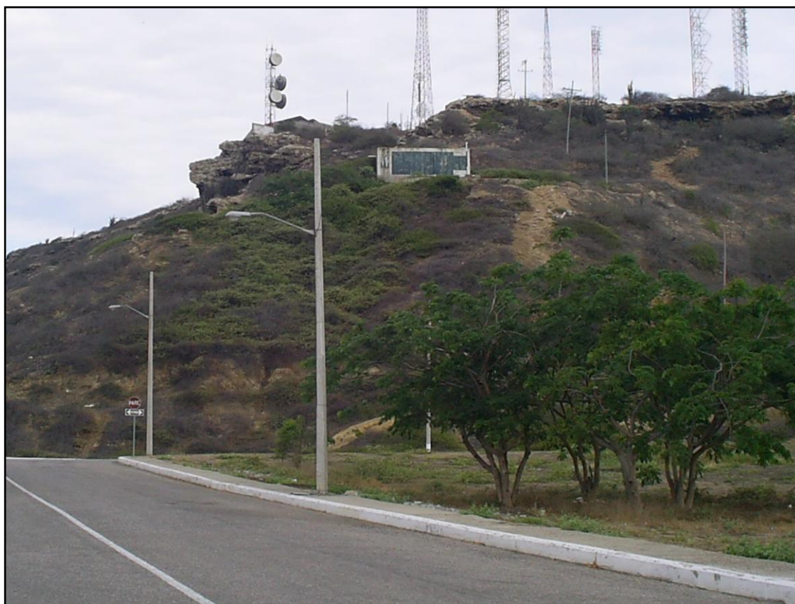
Figura. 3.13 CISTERNA DE RECEPCION Y DESCARGA DE AGUA EN EL CERRO
