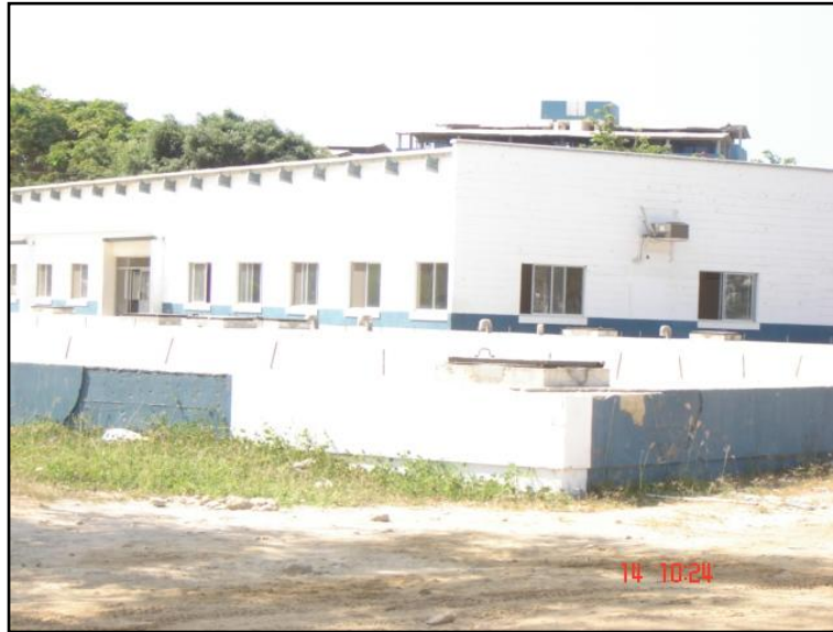
Figura. 1.12 CISTERNA PRINCIPAL Y VALVULAS PRINCIPALES
