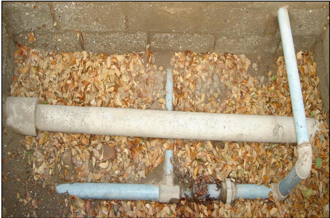
Figura. 3.16 TUBERIA DE 1 PULGADA PARA EL ENVIO DE AGUA A LAS VILLAS DE OFICIALES
