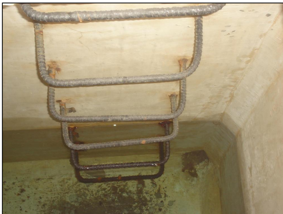
Figura. 3.3 INSPECCION INTERNA DE CISTERNA PRINCIPAL DE ALMACENAMIENTO DE AGUA
