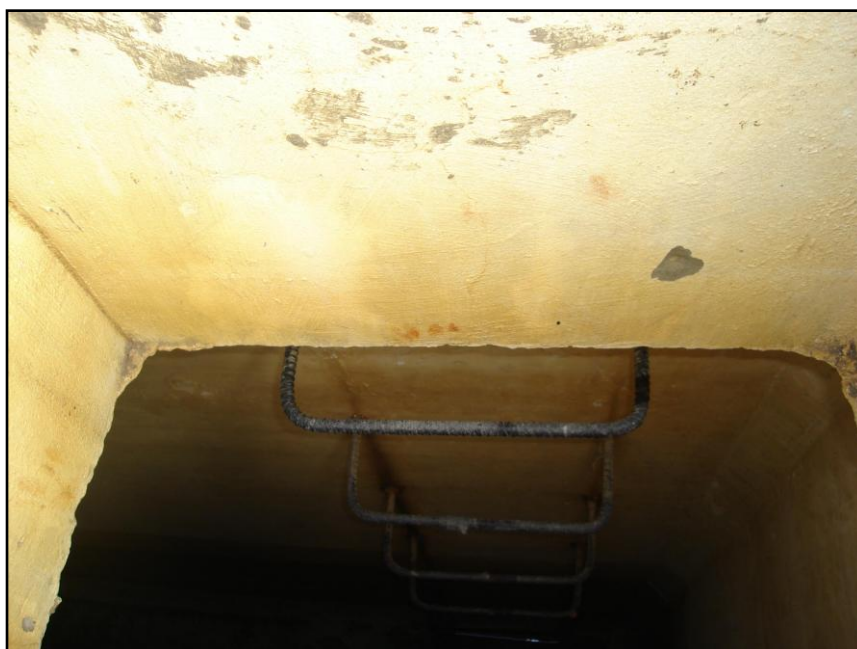
Figura. 3.4 INSPECCION INTERNA DE CISTERNA PRINCIPAL DE
