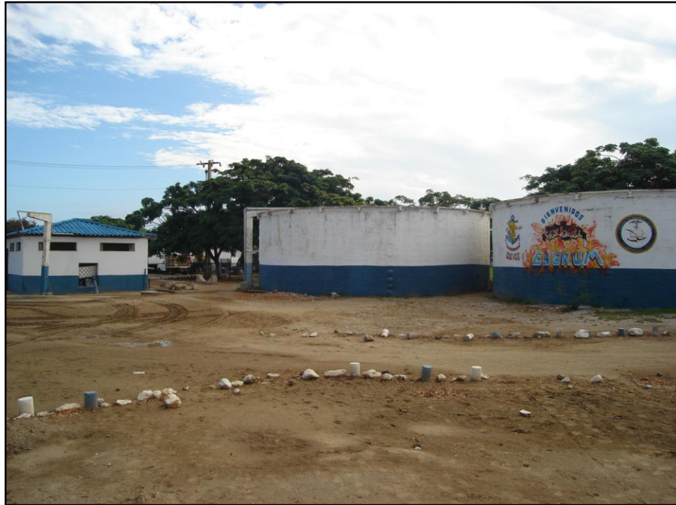
Figura. 3.8 TANQUES DE ALMACENAMIENTO CIRCULARES DE CONCRETO
