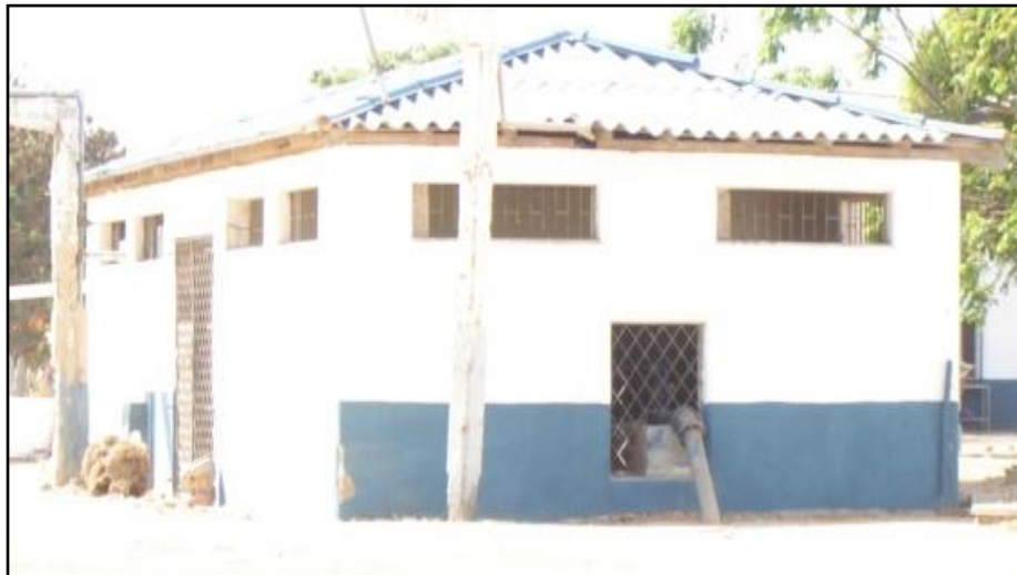
Figura. 3.17 VISTA EXTERIOR DEL CUARTO DE BOMBAS
