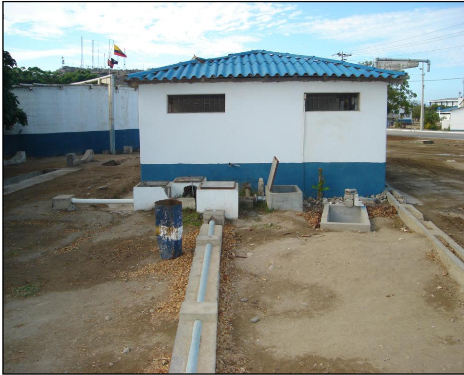
Figura. 3.19 TUBERIA DE INGRESO AL CUARTO DE BOMBAS
