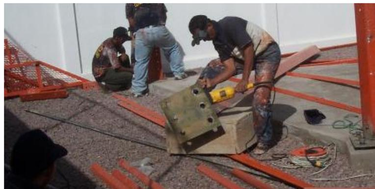
FIGURA 2.16 COLOCACIÓN DE PATA DE TORRE
