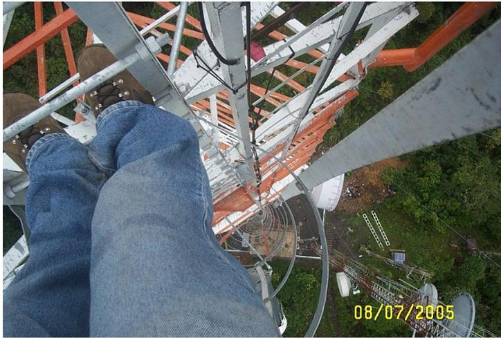
FIGURA 2.2 ANILLOS DE SEGURIDAD
