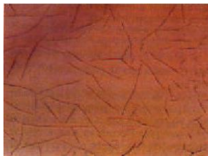
Figura 2.6 Agrietamiento
