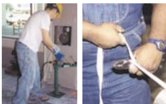
Fig. 2.4: Posturas más seguras en el trabajo de mantenimiento eléctrico, se puede observar ayuda mecánica en el izado de cables. Fuente principios ergonómicos, www.elergonomista.com
