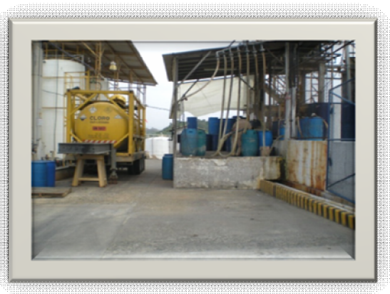
Foto 1. Área de Despacho
