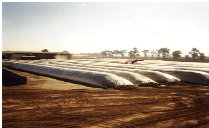
c. Silo chorizo concluido
