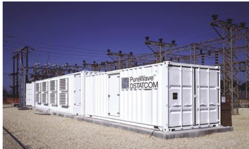
FIGURA 1.16 Foto de un DSTATCOM de marca PureWave
