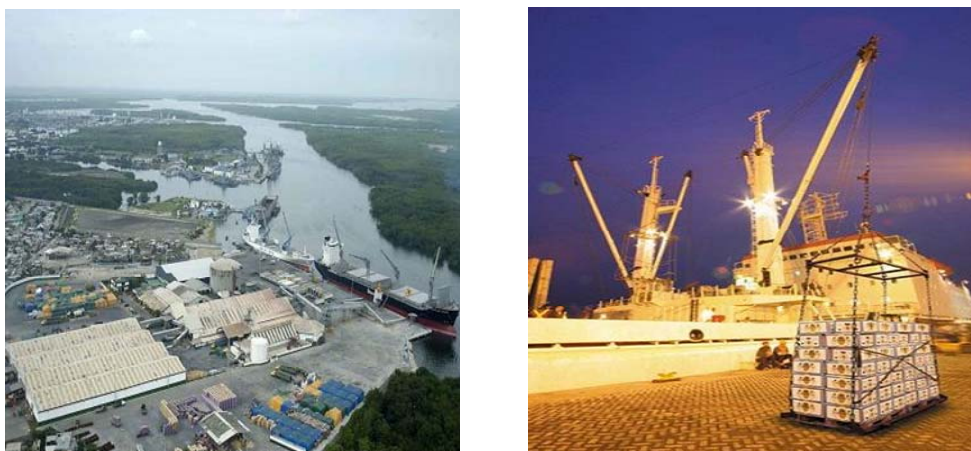
Figura 1.3 Terminal Portuario de Fertisa
