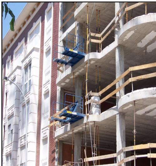
**FIGURA 4.21. PLATAFORMAS DE CARGA Y DESCARGA**
