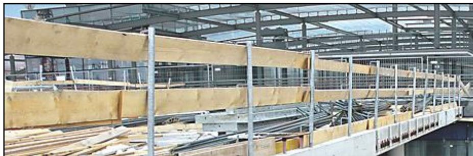
**FIGURA 4.16. BARANDILLAS DE SEGURIDAD EN BORDES Y HUECOS**
