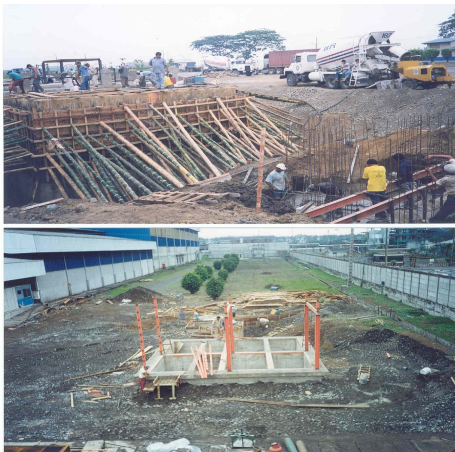
FIGURA 2.17 OBRAS CIVILES DE LA CISTERNA DE LA ESTACIÓN DE BOMBEO DEL CLARIFICADOR
