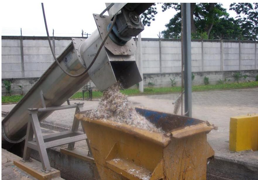
**FIGURA 1.17 SACA BASURAS DEL CANAL DE EFLUENTES
