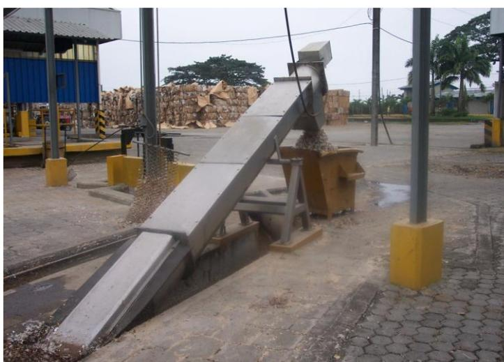
**FIGURA 1.16 SACA BASURAS DE CANAL DE EFLUENTES
