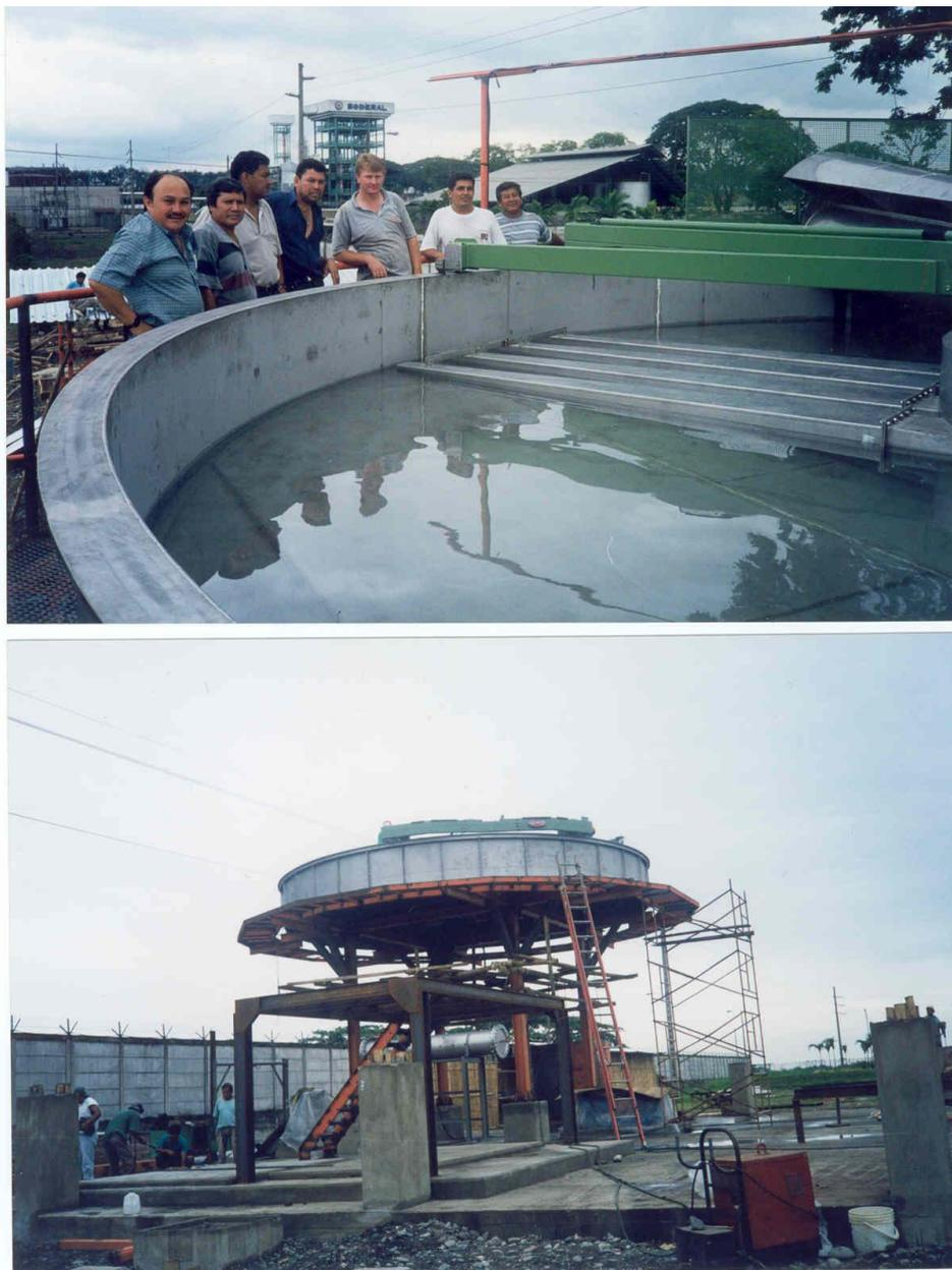
**FIGURA 2.18 PROCESO DE MONTAJE DEL CLARIFICADOR KROFTA**
