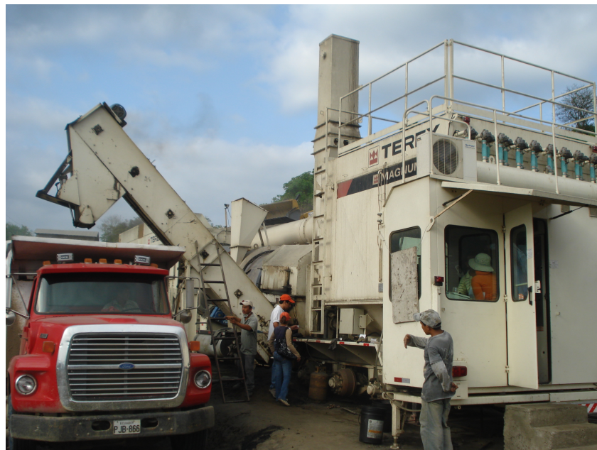
Fig. 4.1.7 – Descarga de Base Asfáltica en Volqueta
