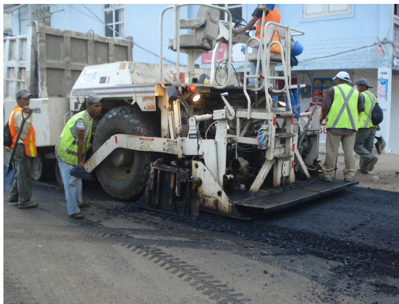
Fig. 4.3.2 – Colocación de la Base Asfáltica
