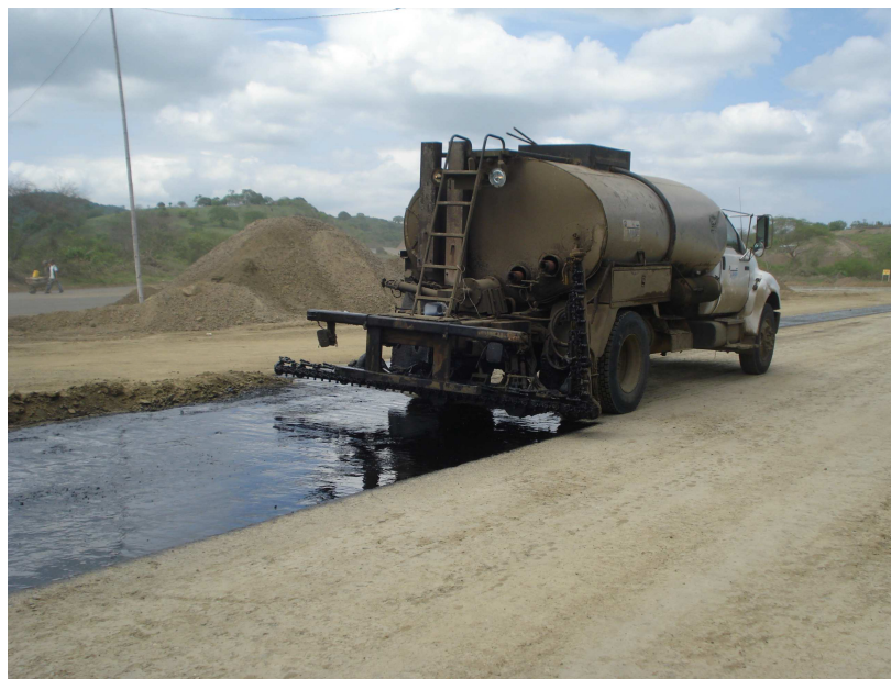
Fig. 4.3.1 – Imprimación asfáltica (sellado)
