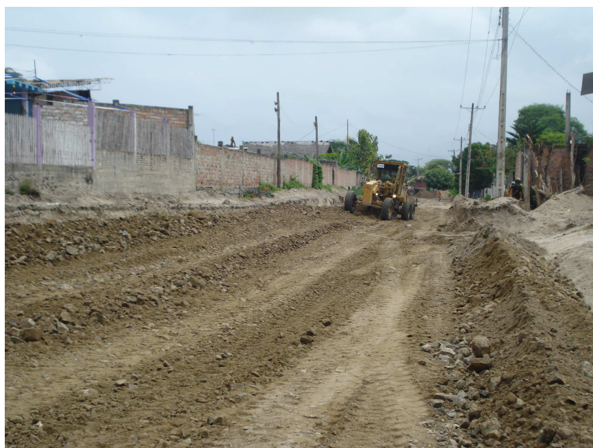
Fig. 3.3 – Mezcla de Material de mejoramiento.
