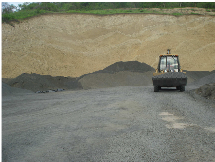
Fig. 4.1.3 – Agregado utilizado para la Mezcla
