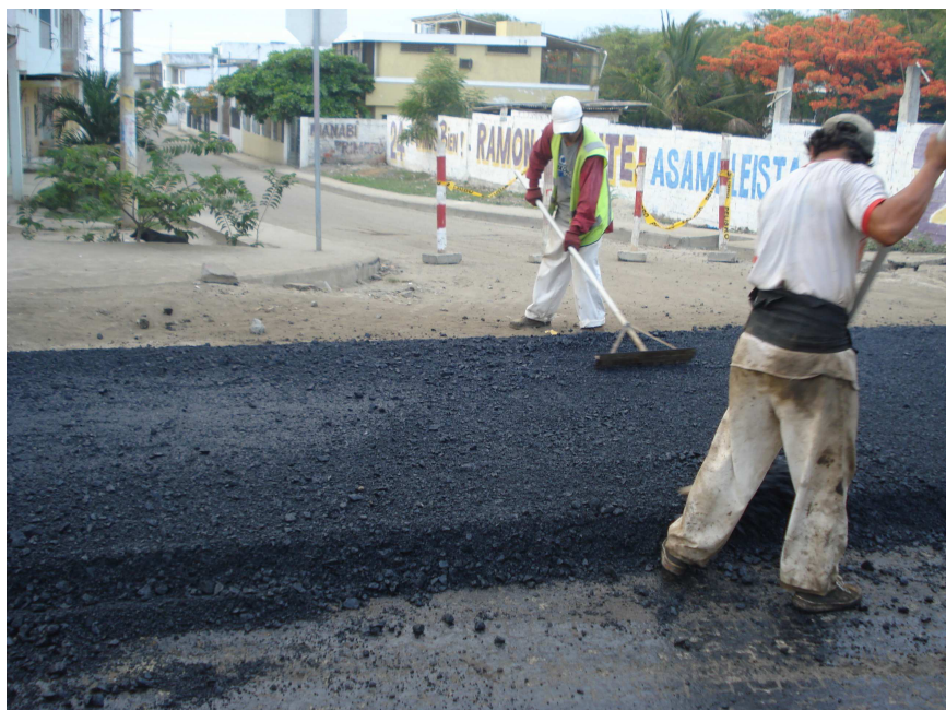
Fig. 4.3.3 – Retiro de exceso de material
