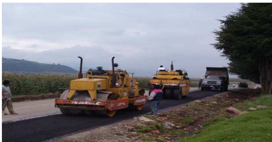
Fig. 4.3.4 – Compactación con rodillo Metálico Liso y Con Rodillo Neumático
