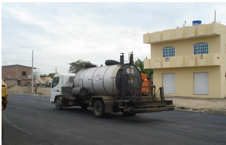
Fig. 4.2.2 – Imprimadora de asfalto
