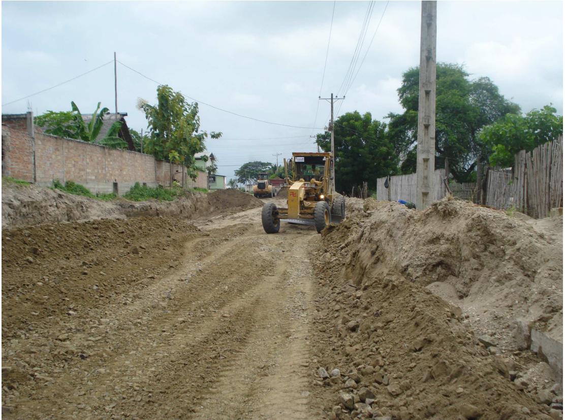
Fig. 3.1 – Proceso de mezclado del material de mejoramiento
