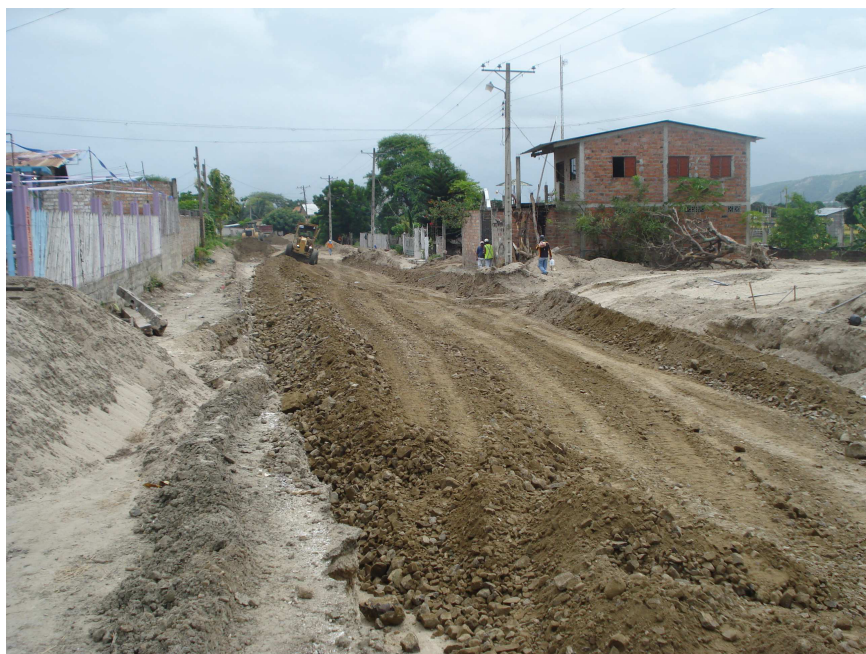
Fig. 3.2 – Mezcla del material con Motoniveladora
