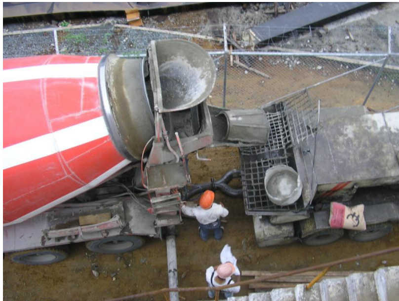
Empleo de Mixer y equipo de bombeo de Hormigón para la fundición del tanque de Aireación y Anóxico.
