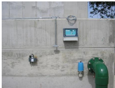
SENSOR DE NIVEL TANQUE HIPOCLORITO DE SODIO
