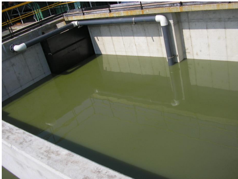
Vista de la Prueba de Estanqueidad.
