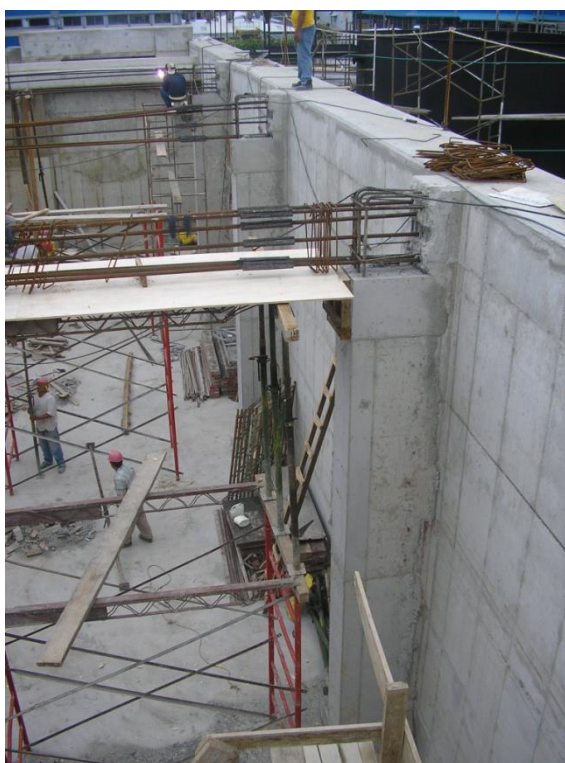
Construcción de Vigas en Tanque de Aireación
