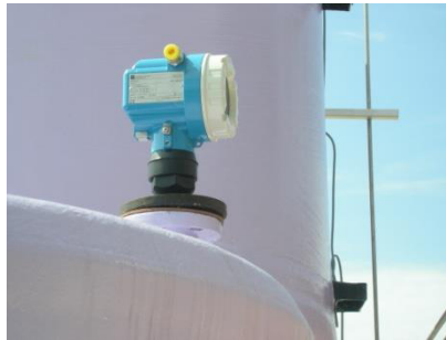
SENSOR DE NIVEL TANQUE HIPOCLORITO DE SODIO
