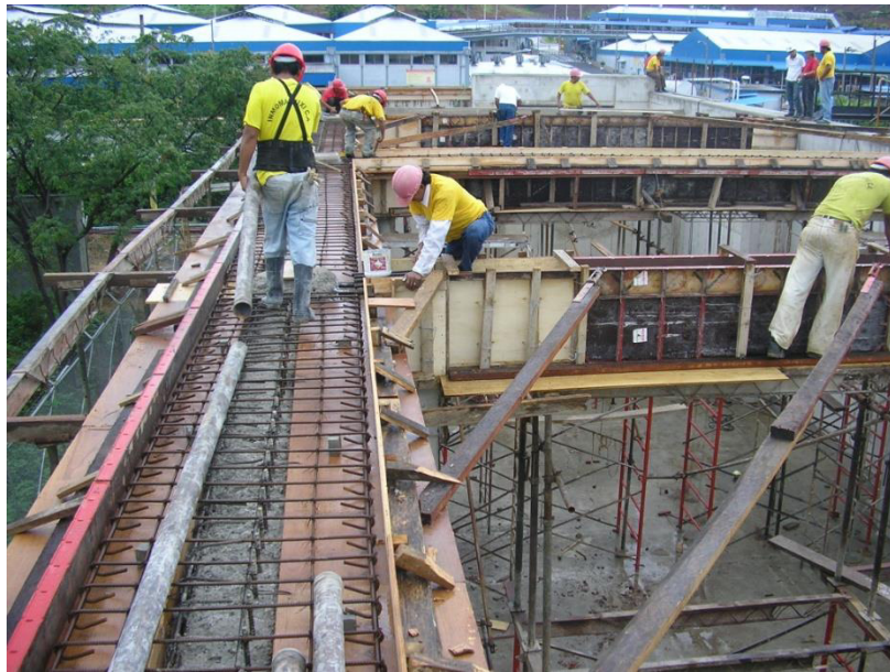
Encofrado de camineras y Vigas en Tanque de Aireación y Anóxico.
