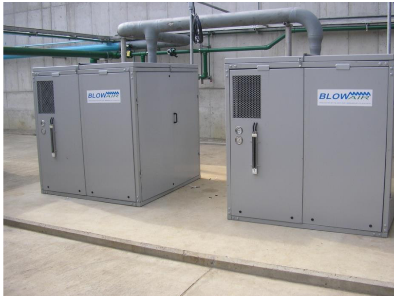
Generadores de Aire para difusores.
