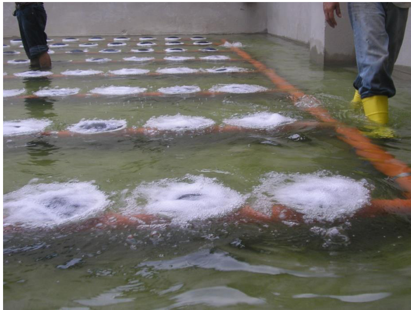
Prueba de Difusores en Tanque de Aireación
