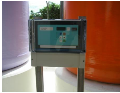
TRANSMISOR SENSOR DE NIVEL SODA - CLORURO
