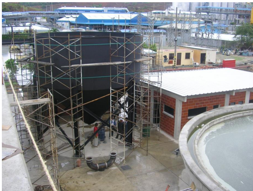
Espesador de Lodos, previo revestimiento con pintura epóxica.
