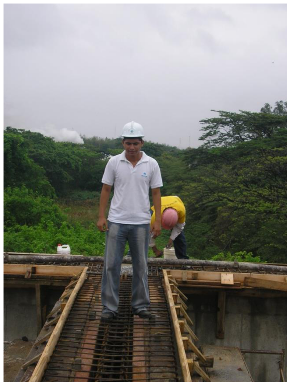
Revisando el encofrado de las vigas que estén libres de residuos.
