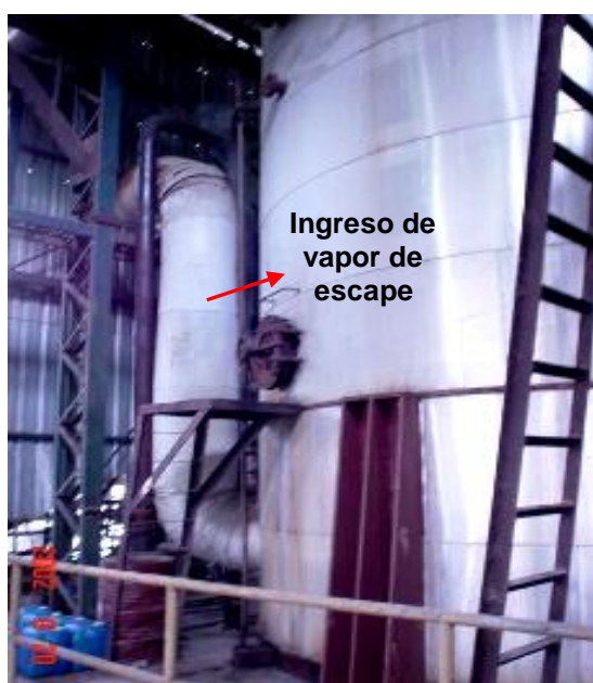
FIGURA 6.23 PRE-EVAPORADOR PRINCIPAL CON UNA ÁREA DE CALENTAMIENTO DE 25.000 Ft 2
