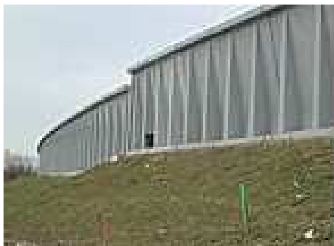
Fig.3.11 Muro con contrafuerte
