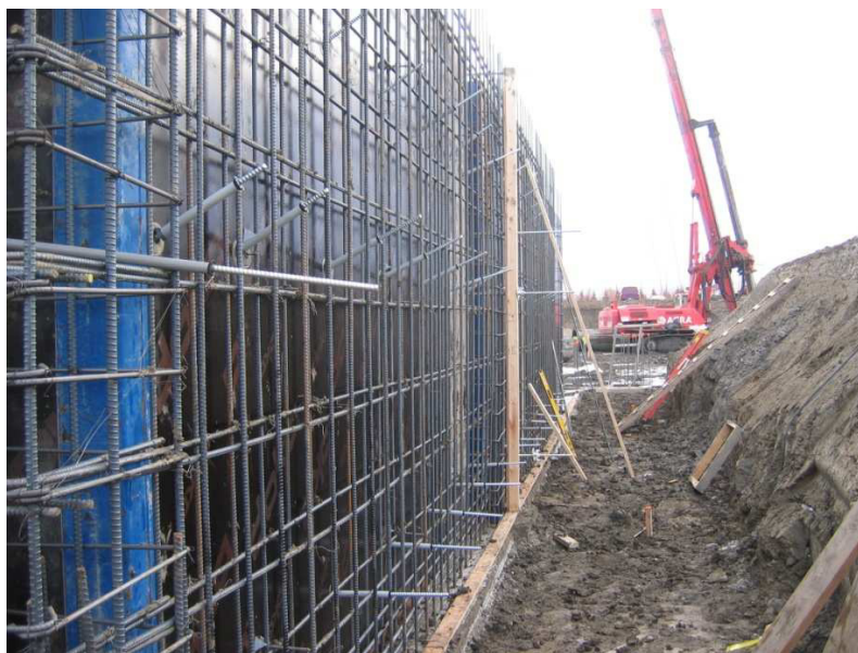
Figura 4.9 Figura de la colocación del acero de refuerzo en el muro HA
