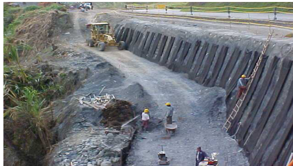
Figura 5.8 Colocación del Subdren en el espaldón
