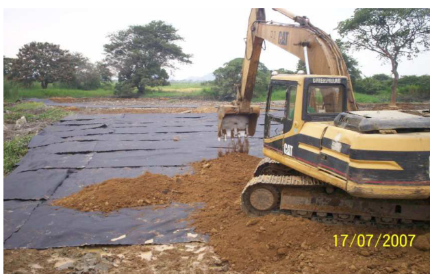
Figura 5.14 Colocación del Material de Relleno
