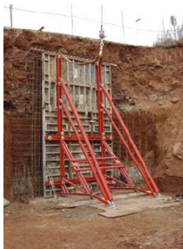
Figura 4.8 Figura de encofrado del muro de hormigón.
