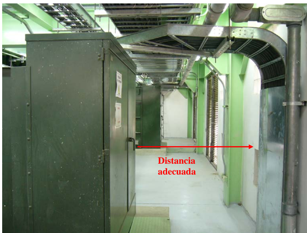
Figura 5.8 Distancia entre pared y transformadores
