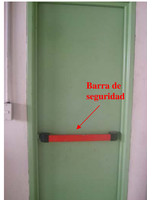
Figura 6.4 Barra de seguridad
