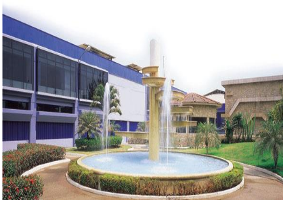
Figura 2.7 EDIFICIO PRINCIPAL – ÁREA ADMINISTRATIVA
