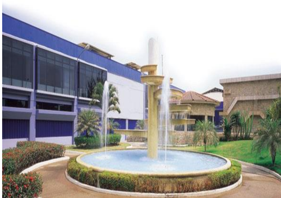
Figura 2.7 EDIFICIO PRINCIPAL – ÁREA ADMINISTRATIVA
