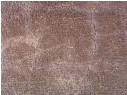
Fotografía 1. Fisura de afogado (fisuras en mapa)
