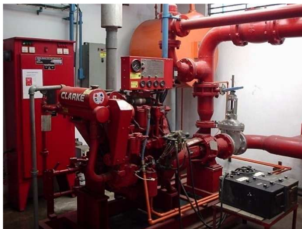
FIGURA 4.1 PANELES DE CONTROL PARA LAS BOMBAS
