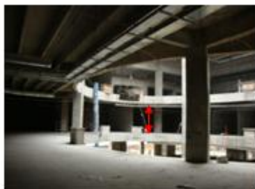
FIGURA 2. RIESGO MECÁNICO A
