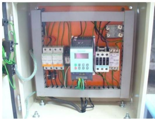
**FIG. 2.22 FOTOGRAFÍA DEL MONTAJE TERMINADO DE COMPONENTES DEL TABLERO DE CONTROL**
