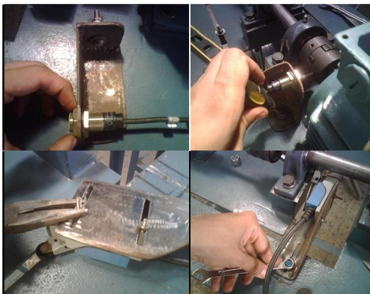
**FIG. 2.26 PROCESO DE MONTAJE DE SENSORES DEL SISTEMA DE CONTROL**
