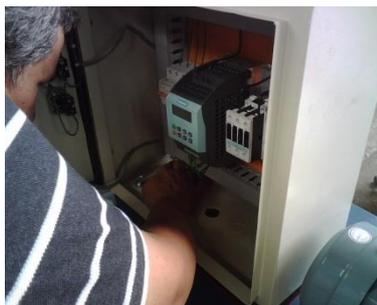
**FIG. 2.25 FOTOGRAFÍA DEL MONTAJE DEL TABLERO DE CONTROL**
