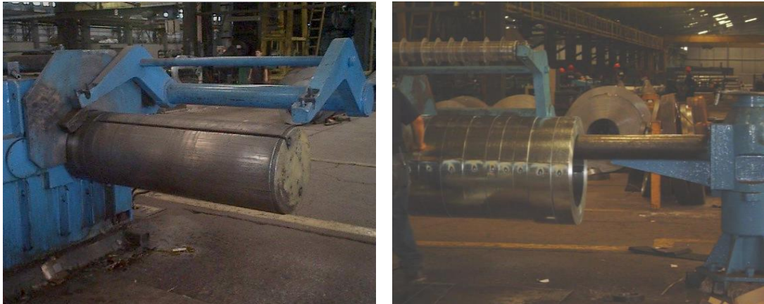
FIGURA 3.6 DESMONTE DE FLEJES DEL ENROLLADOR
