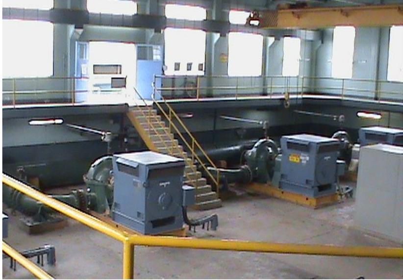
Figura 1.3. Motores trifásicos de 1250 HP, 4160 V, 160 A
