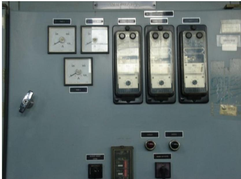
Figura 1.4. Protecciones analógicas de sobre corriente del interruptor general de entrada a EB1
