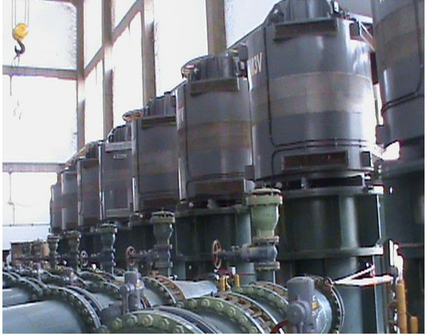
Figura 1.1. Motores trifásicos de 3000HP, 13800 V, 116 A
