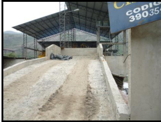
Figura 2.8 Recepción de Minerales en la Tolva de Gruesos
