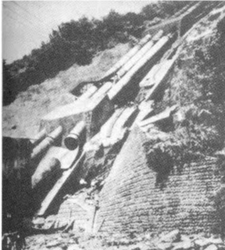
FIGURA 2.11 TUBERÍA DE PRESIÓN ROTA DE CENTRAL OIGAWA,
