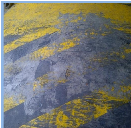
Foto 7 ENTRADA DE BODEGA 1 MATERIA PRIMA
