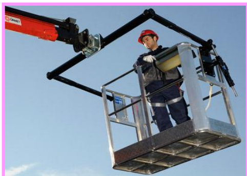
5. Montacarga sube al despachador a la percha
