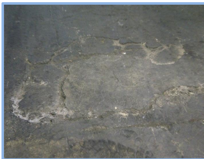
Foto 1 PISO DE BODEGA 1 MATERIA PRIMA
