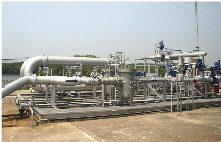
**Figura 2.10.-** Filtros y Medidor Másico de Caudal.
