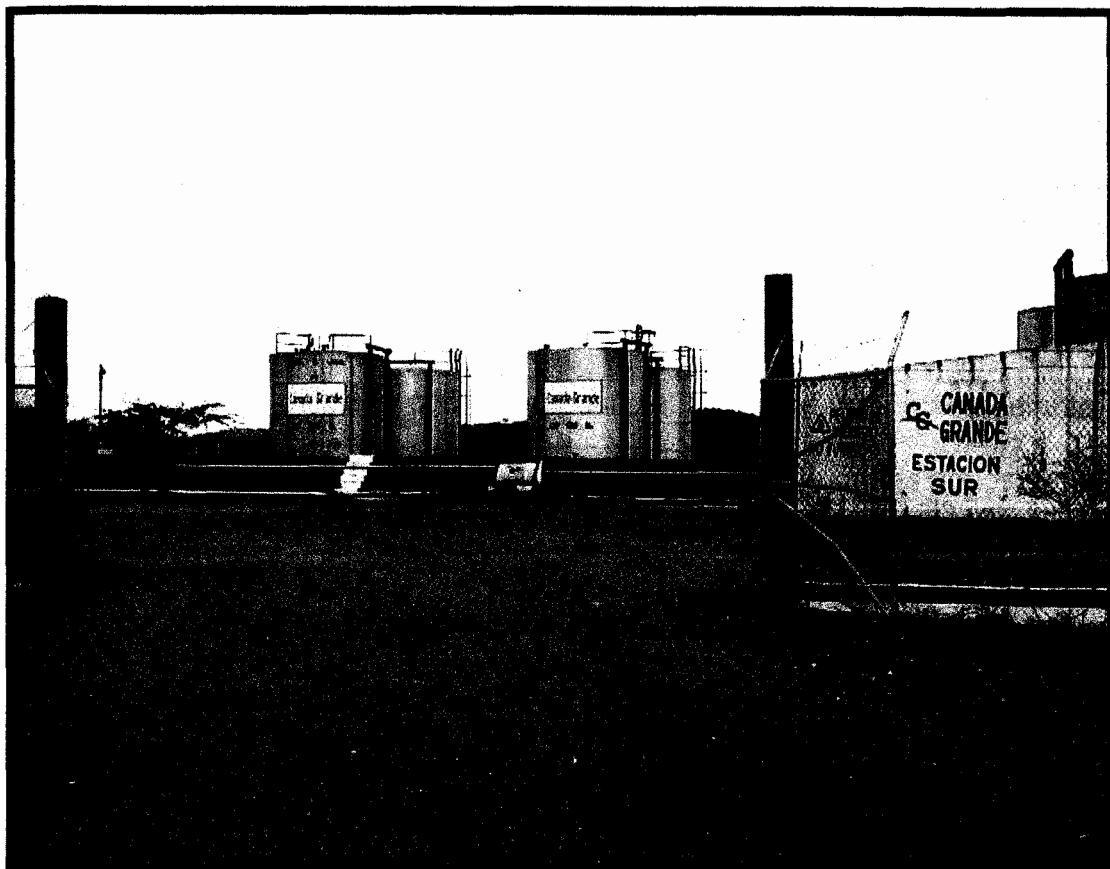
FIGURA 3.3 ESTACIÓN DE PRODUCCIÓN SUR
