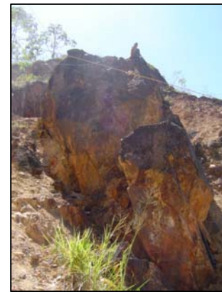
Fig. 3. Bloque desprendido en la Q. Matalanga-Portovelo.
