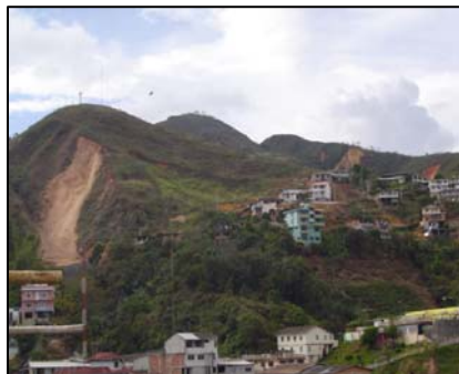
Fig. 2. Deslizamiento en el Cerro el Calvario. Zaruma.
