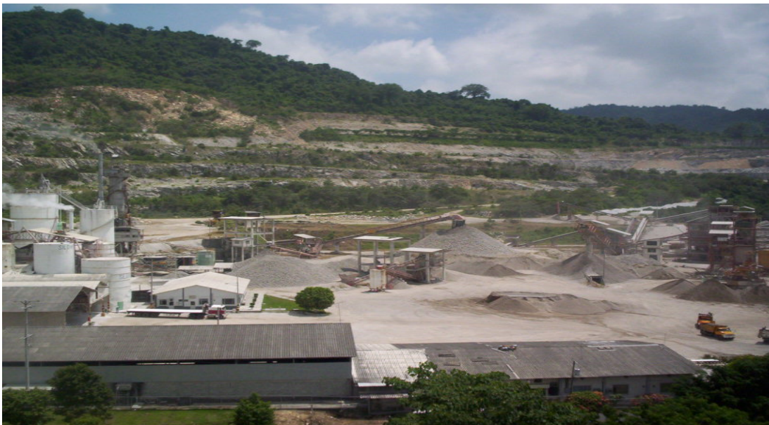
Figura 1. Vista de la Planta Huayco de Calizas Huayco S.A.
