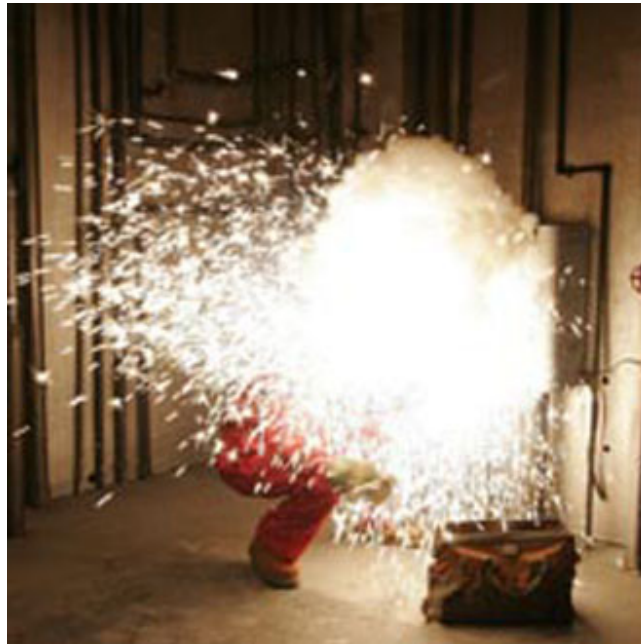
Figura 1.3 Trabajador que es afectado por una descarga de arco.
