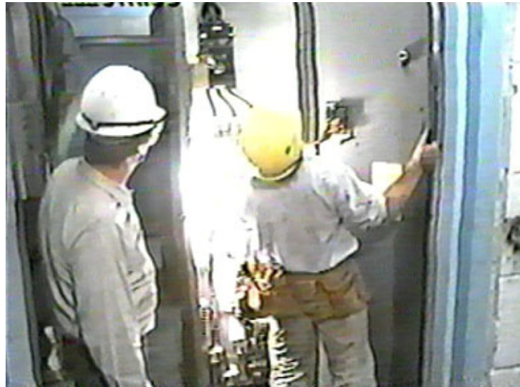
Figura 1.2: Personal trabajando en barras principales
