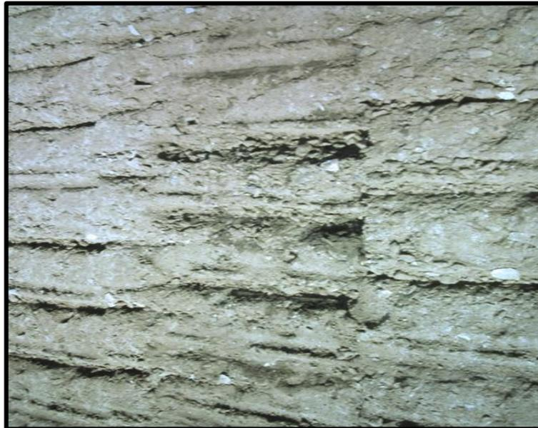
**Ilustración 8. 20 Marcas de Equipos sobre Hormigón Endurecido,
