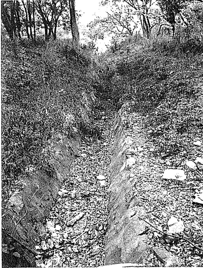
Figura 27 Tramo 3: Canal de sección trapezoidal.
