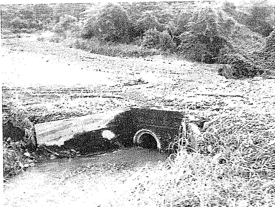
Figura 33 Batería de tuberías de hormigón armado.
