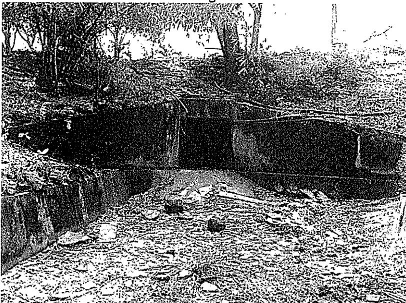
Figura 3 Estructura en la salida de la alcantarilla 1: muros de ala, rápida lisa y canal.
