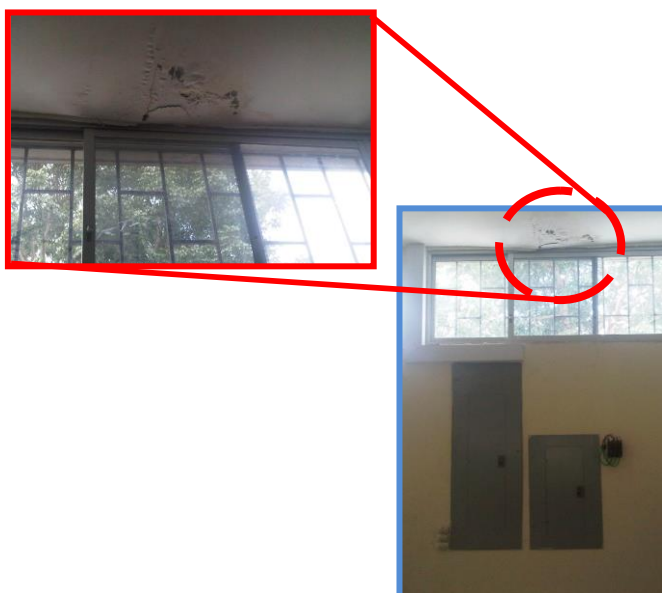
Figura 3.9: Condiciones de Cajetines Eléctricos y Losa. Fuente: Marcos Olaya Aguilar.
