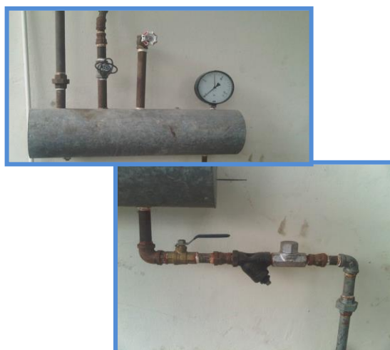
Figura 3.16: Tuberías de vapor del caldero.
