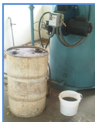
Figura 3.17: Tanques de combustible.
