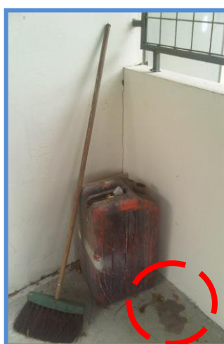
Figura 3.18: Derrames de combustible en el área del caldero.
