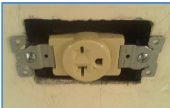
Figura 3.6: Condiciones de toma corriente Fuente: Marcos Olaya Aguilar.
