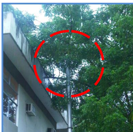
Figura 3.12: Ubicación de chimenea de caldero.
