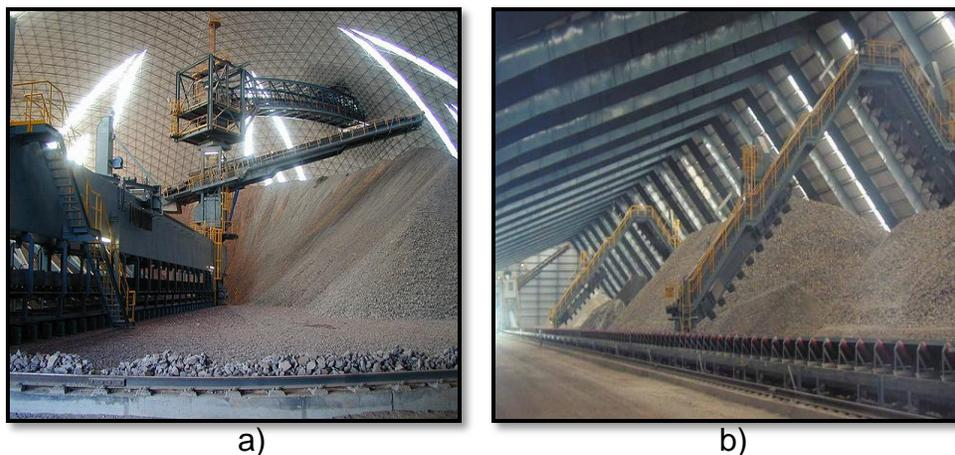
**Figura 1.13 Pre-homogeneización a) Lecho Circular b) Lecho Longitudinal**
