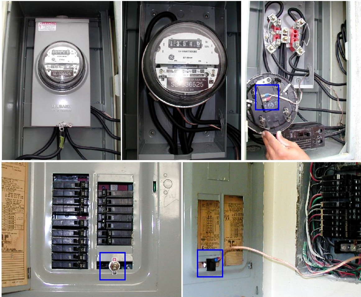
Fig. No. 2.3 apertura manual de la continuidad del circuito eléctrico de la bobina de potencial, mediante la utilización de la interconexión serial de un interruptor (switch), permitiendo de esta manera efectuar el control de la desviación de la energía consumida. Se puede apreciar claramente, que en el presente caso se detectó la presencia del interruptor (switch), instalado en el panel de distribución general.
