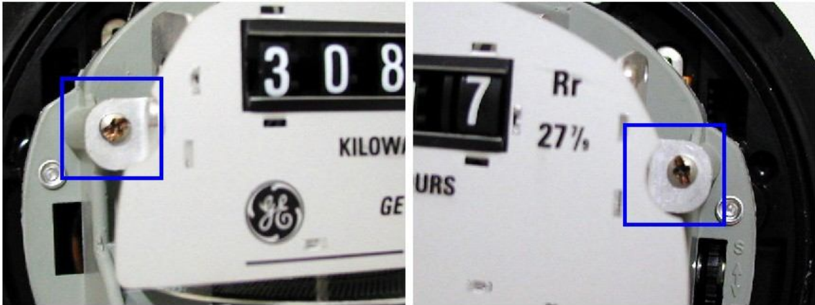
Fig. No. 2.8 se aprecia que las cabezas de los tornillos sujetadores de la unidad registradora, se encuentran desgastadas (melladas) por la continua manipulación para alterar la secuencia normal de registro de lectura del medidor de energía eléctrica.
